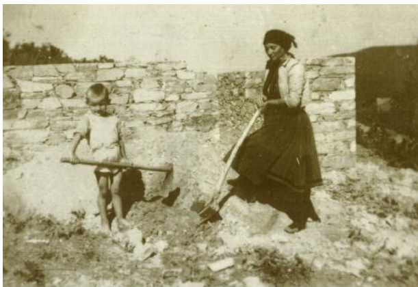
7. Μητέρα με τον γιό της συμβάλλουν στο κτίσιμο του σπιτιού. Δροσσοπηγή 1952 (αγνώστου φωτογράφου παραχώρηση του Μορφωτικού Συλλόγου Δροσσοπηγής « Η Πρόοδος»).
